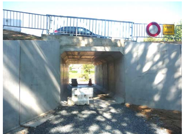
passage sous la route de Saint-Victor
