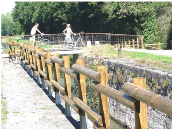
garde-corps sur l'écluse
