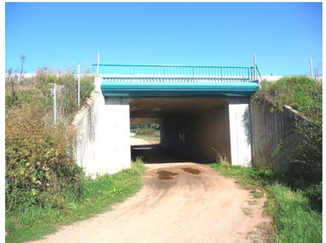
passage sous la A 714
