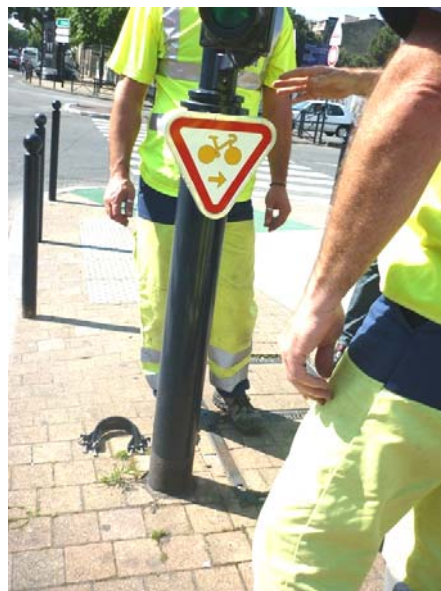
A Bordeaux, pose d'un panneau de « tourne-à-droite »
